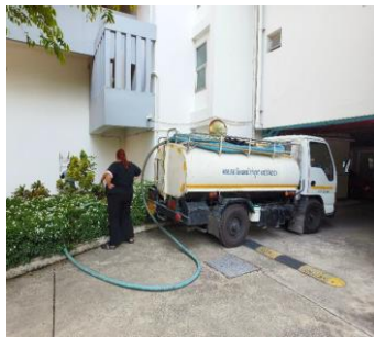
ภาพที่ 2.2-17 การสูบล้างและไขนํ้าจากบ่อบำบัดน้ำเสีย
