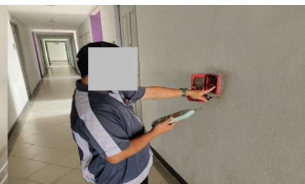
ภาพที่ 2.2-15 การตรวจเช็คระบบป้องกันและเตือนอัคคีภัย
