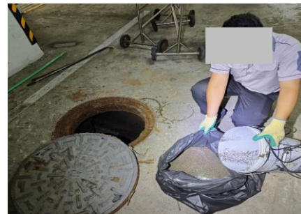
ภาพที่ 2.2-17 การสูบล้างและไขนํ้าจากบ่อบำบัดน้ำเสีย
