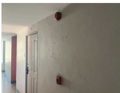
Alarm Bell และ Fire Alarm Manual Station
