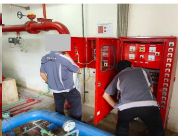
ภาพที่ 2.2-15 การตรวจเช็คระบบป้องกันและเตือนอัคคีภัย
