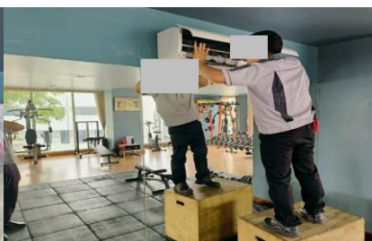
ภาพที่ 2.2-24 การล้างทำความสะอาดเครื่องปรับอากาศ
